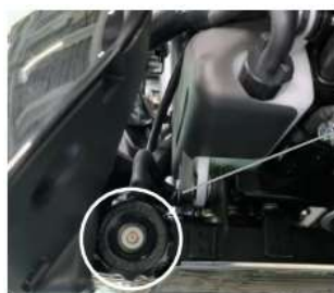
Tampa do depósito de água
